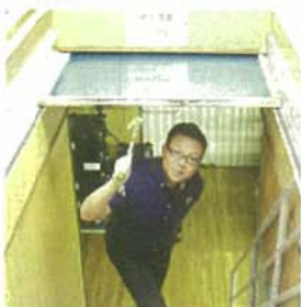
自作の引き戸を設置し障子から逃げる熱をシャットアウト
